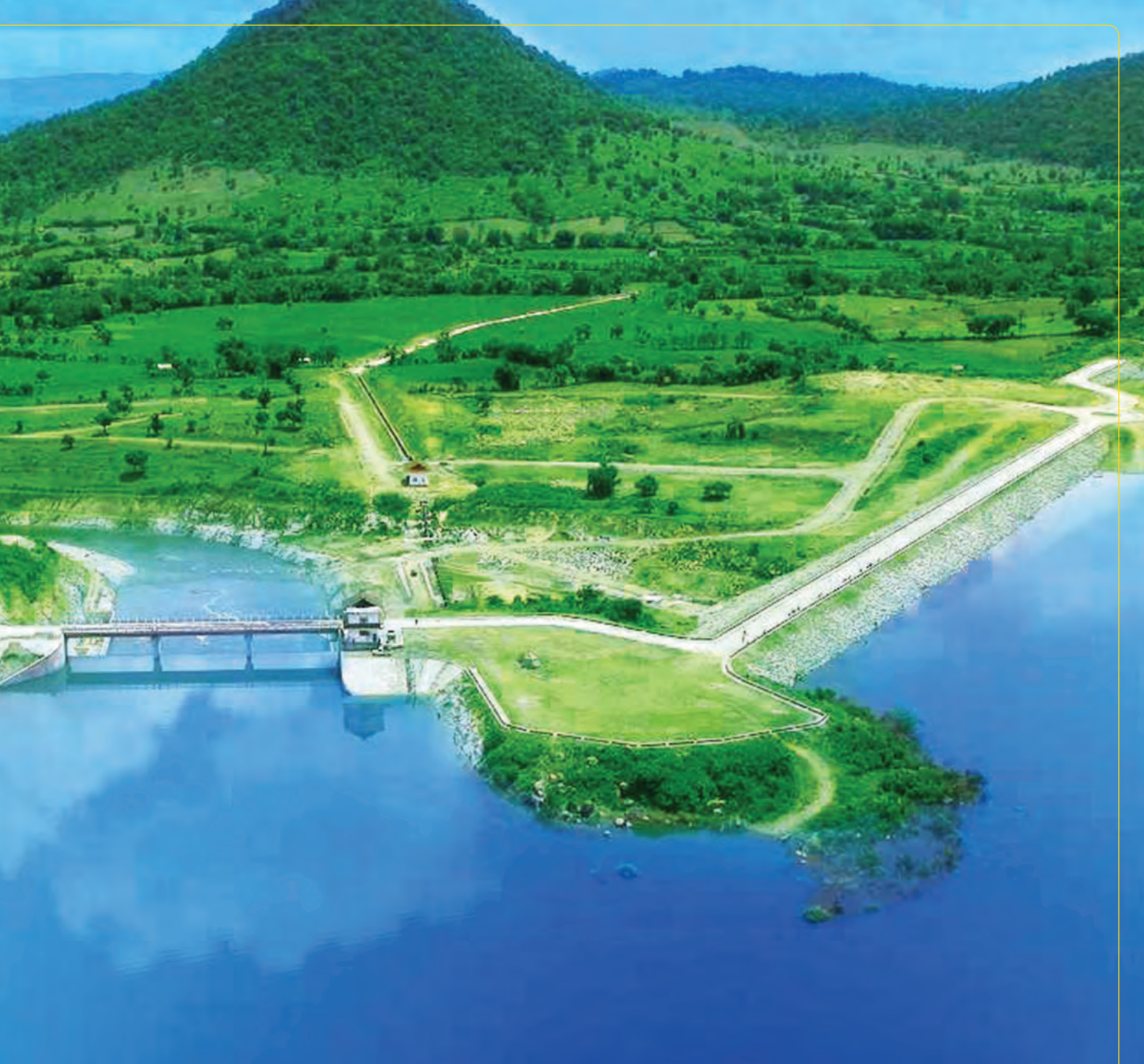
Bendungan Batu Bulan, Sumbawa - Nusa Tenggara Barat
