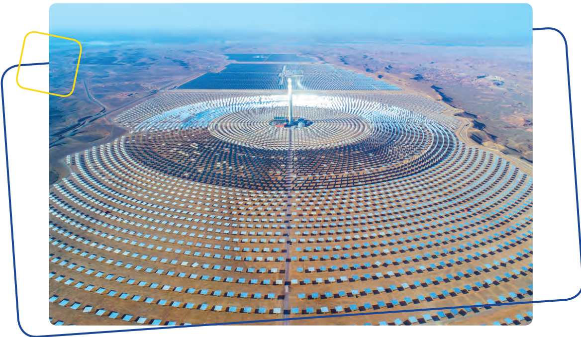
Gambar 10.1 Pembangkit Listrik Tenaga Surya Nour, Maroko: Impian Bisnis Brantas Abipraya.
